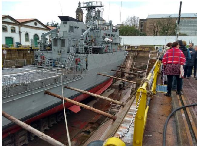
Delante de un dique, recibimos información muy precisa de cómo se estaba realizando la limpieza de fondos del buque Serviola, haciendo referencia a la construcción y funcionamiento de la puerta de cierre del dique y trabajos que se habían realizado para la construcción del mismo.
